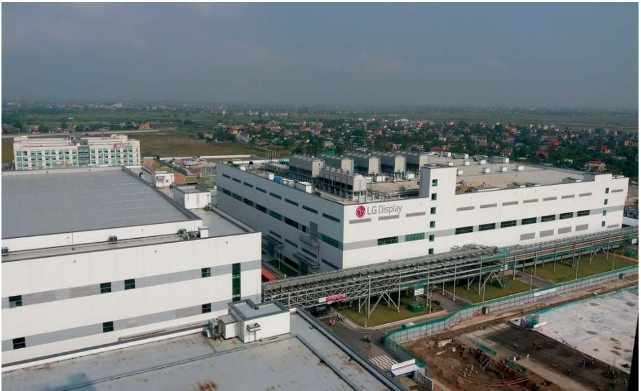
LG DISPLAY H3 PROJECT - HAI PHONG
