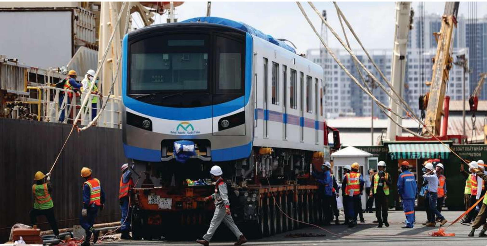
TUYẾN ĐƯỜNG SẮT BẾN THÀNH - SUỐI TIÊN
